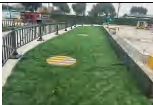
施工时防尘覆盖
