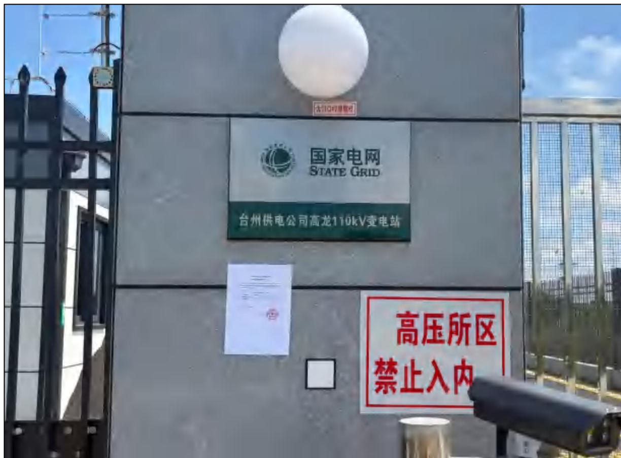
图 9-1 本项目竣工及调试时间现场粘贴公示照片（2026 年 6 月 17 日）
