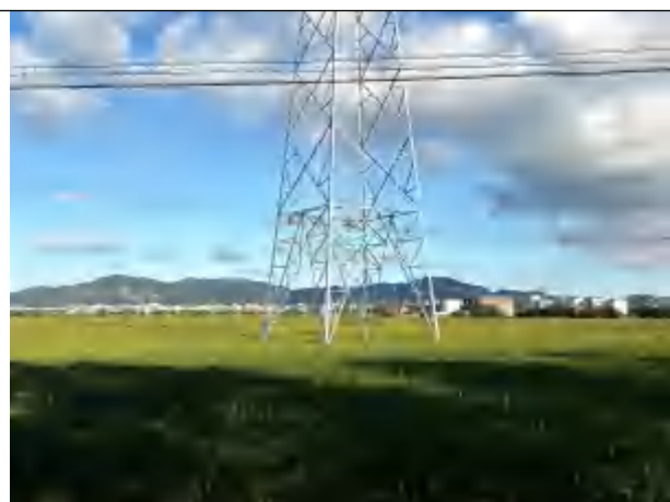
塔基迹地现状
