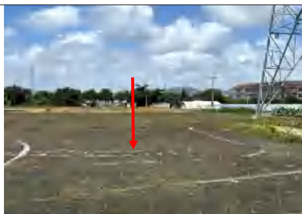
牵张场迹地现状（已复垦）
