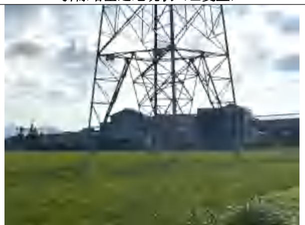
塔基迹地现状
