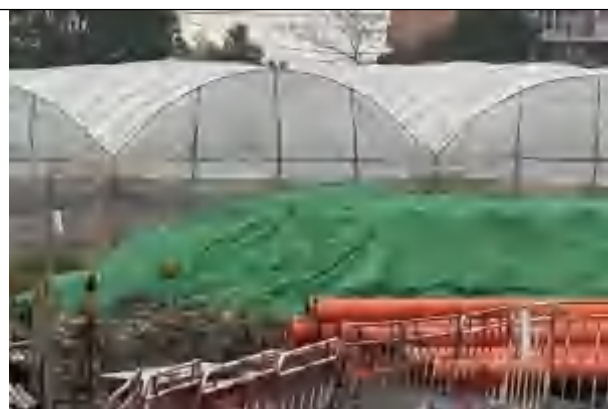
施工期堆土覆盖
