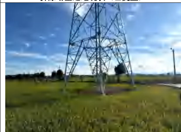
塔基迹地现状
