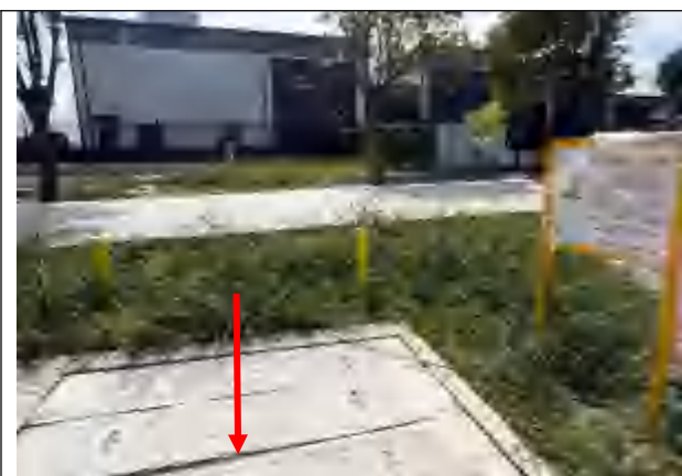
电缆沟迹地现状
