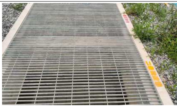
施工期沉淀池
