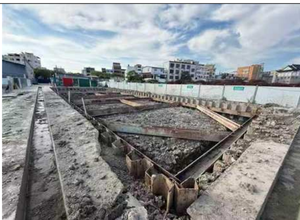
施工期排水沟
