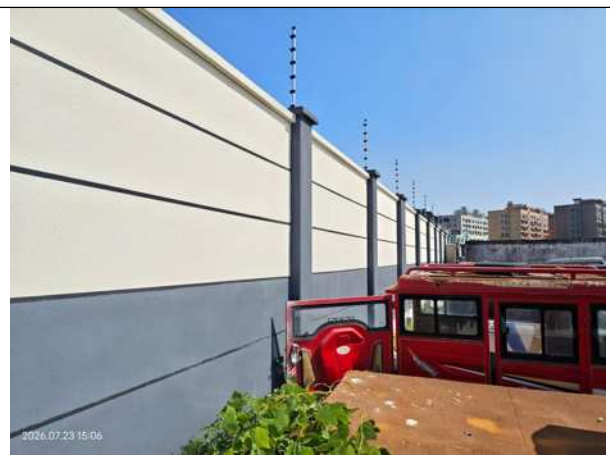
变电站西北侧
