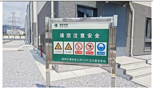
变电站内警告标识
