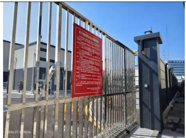
变电站东南侧
