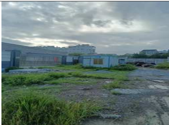
变电站西南侧
