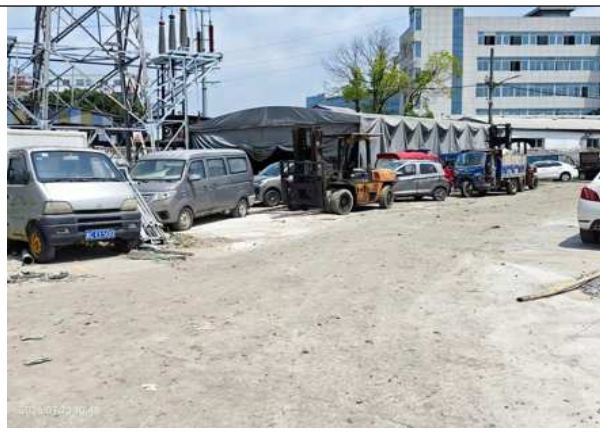
电缆沟迹地现状
