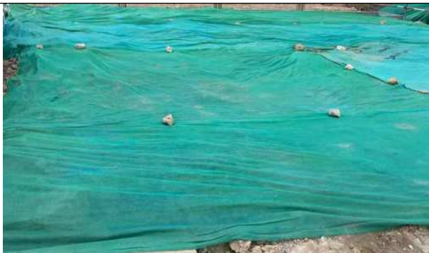
施工期堆土覆盖
