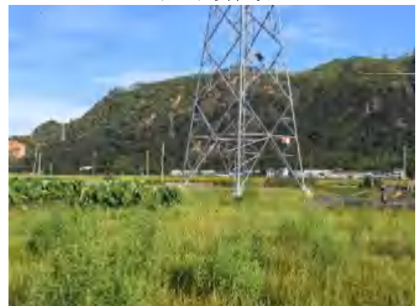
137 号塔基植被现状
