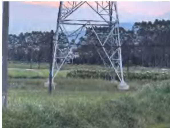
106 号塔基复耕现状
