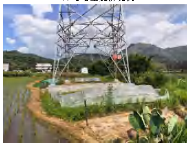
76 号塔基复耕现状
