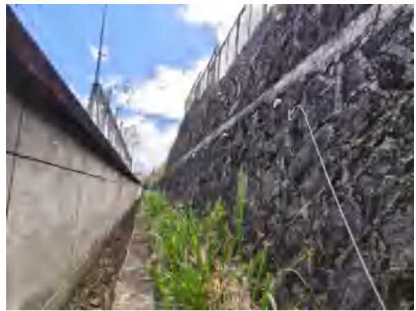
站址南侧现状
