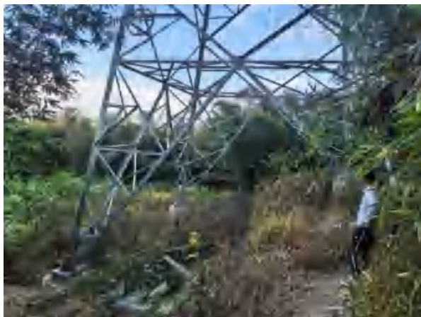
117 号塔基植被现状
