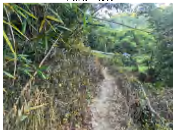
施工便道 1 现状
