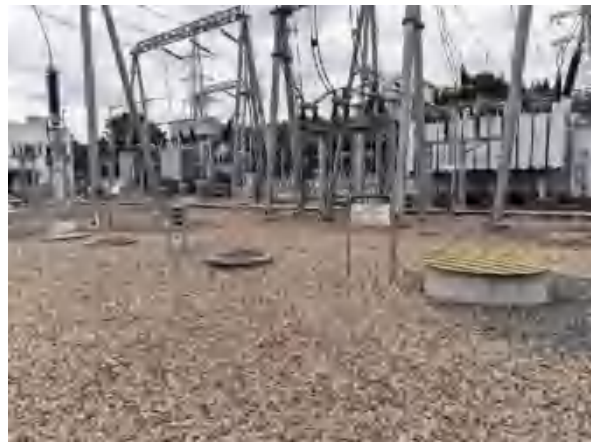
新建事故油池
