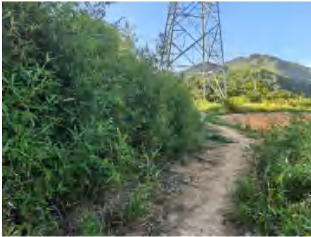
施工便道 2 现状
