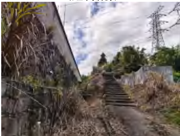
站址西侧现状
