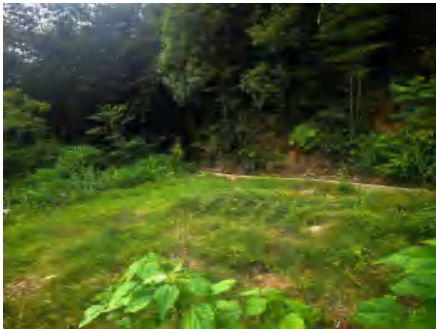
塔基拆除现状（绿化）
