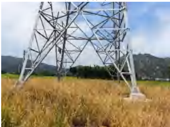
139 号塔基植被现状
