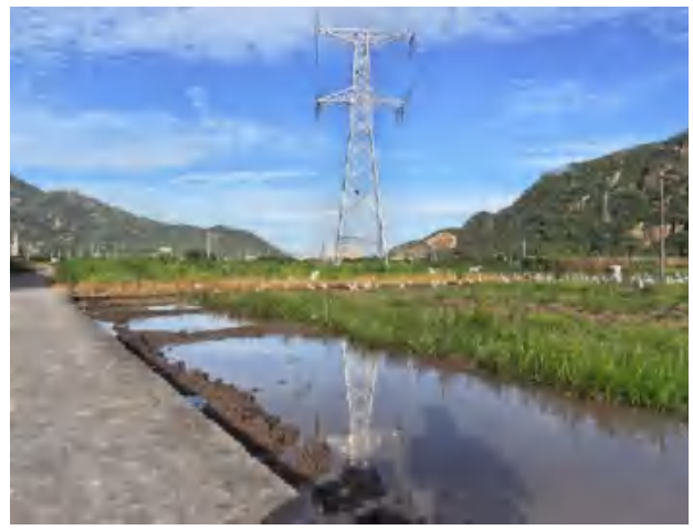
塔基拆除现状（复耕）
