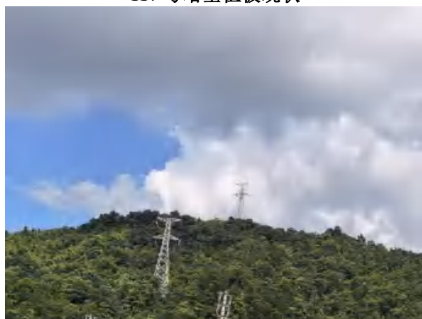
78~79 号塔基之间植被现状
