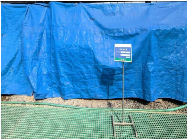
施工期易扬尘物料防尘措施
