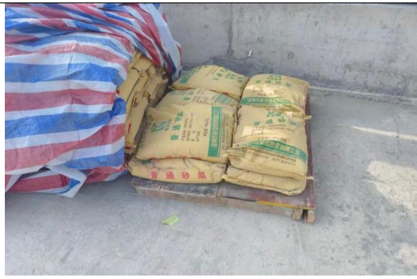
施工期易扬尘物料防尘、防潮措施
