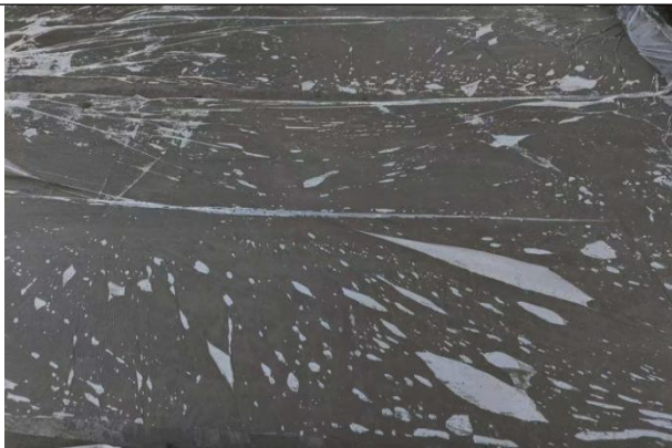
施工期混凝土薄膜养护
