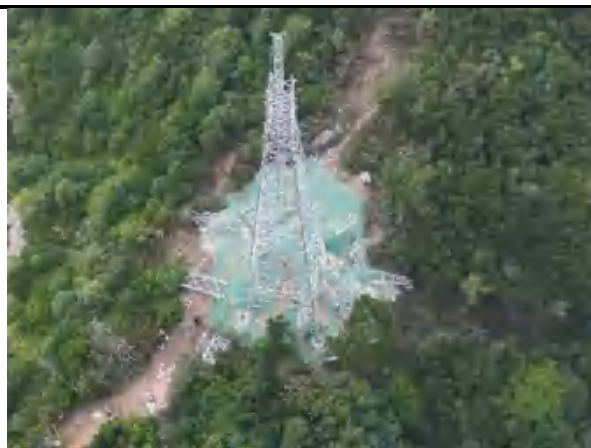
组塔施工密目网遮盖
