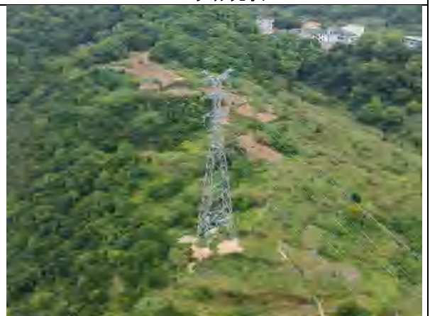
T17 号塔现状
