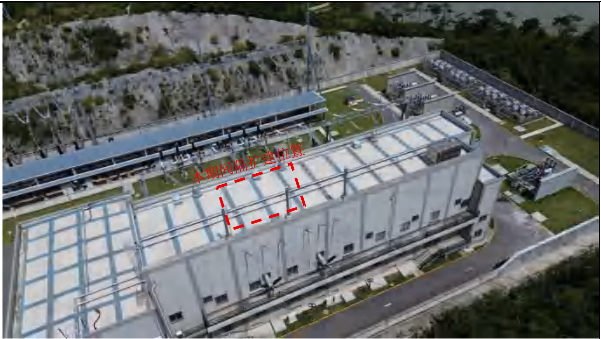
本期间隔扩建（航拍）
