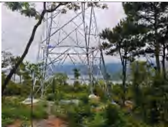
T11 号塔现状
