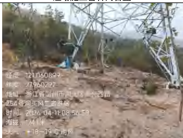
塔基施工区边坡植被恢复
