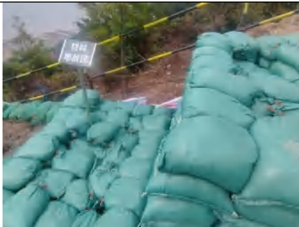
施工材料集中堆放区
