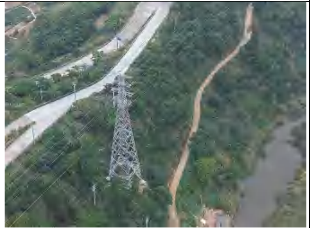
T8 号塔现状
