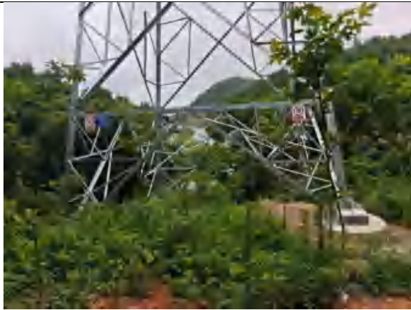
T2 号塔现状
