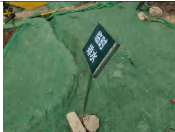
施工临时排水沟
