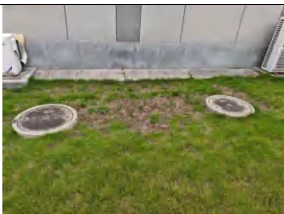
站内化粪池（原有）
