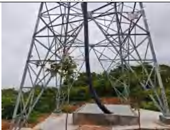
35kV 青中门 3373 线 12#塔现状（本期接入）
