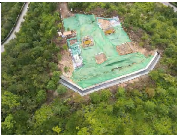
塔基施工密目网遮盖
