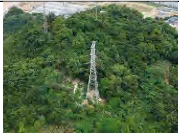
T31 号塔现状
