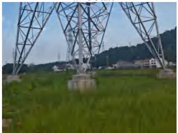
30#塔基恢复情况
