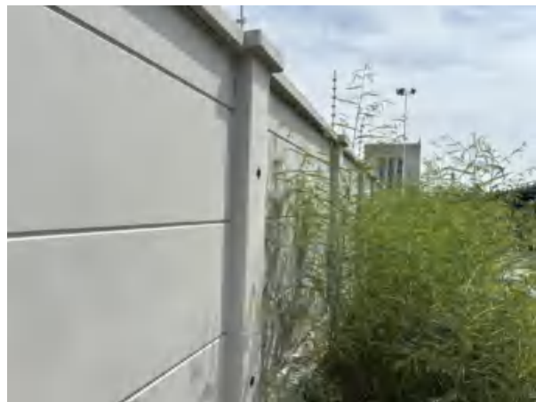
启城变电站厂界南侧
