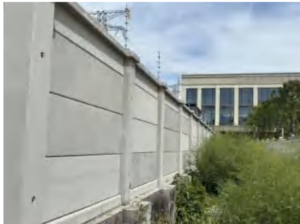
启城变电站厂界东侧
