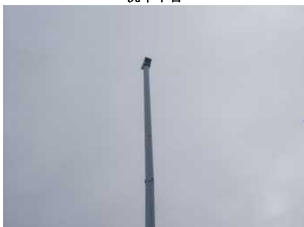
全自动雾状高压喷淋系统
