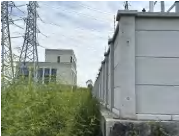
启城变电站厂界北侧
