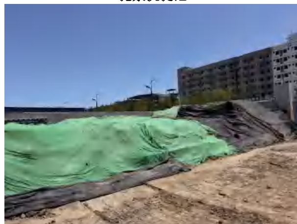
裸土覆盖措施
