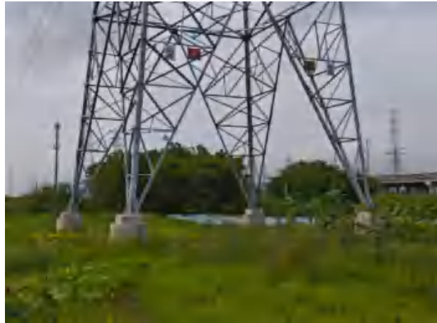
38#塔基恢复情况
