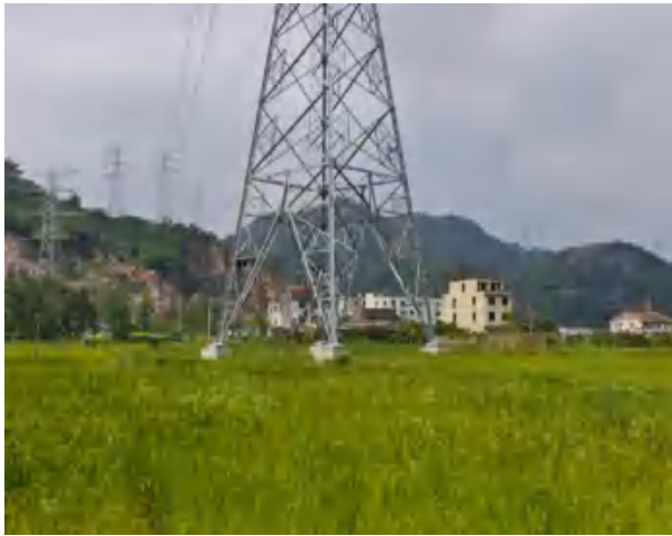
16#塔基恢复情况
