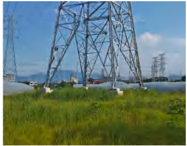
33#塔基恢复情况
