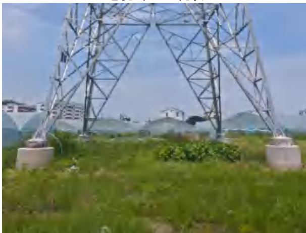
21#塔基恢复情况
