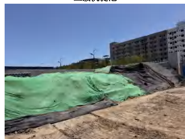
现场土、料存放采取绿网覆盖
