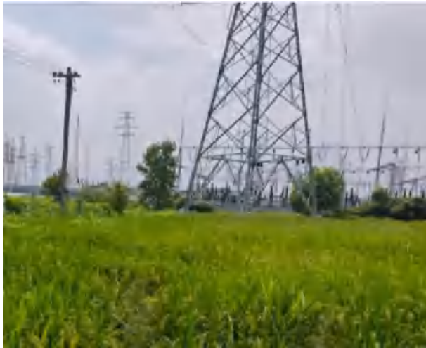
1#塔基恢复情况
