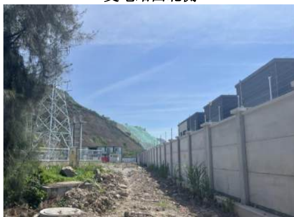
变电站东南侧
