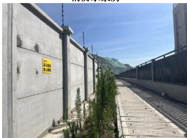
变电站西北侧
