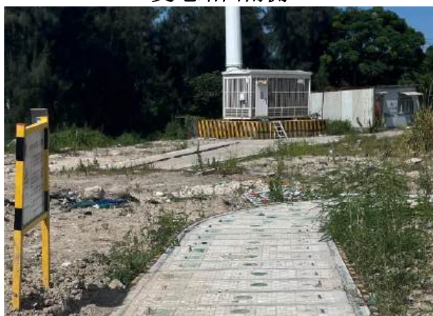
双回电缆迹地现状
