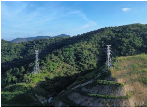
塔基迹地现状
