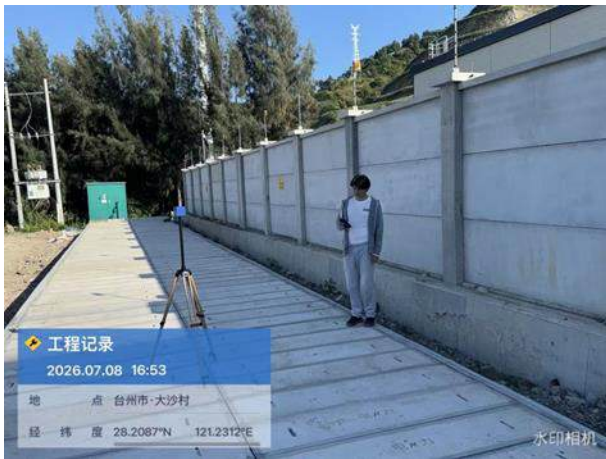
变电站厂界电磁监测
