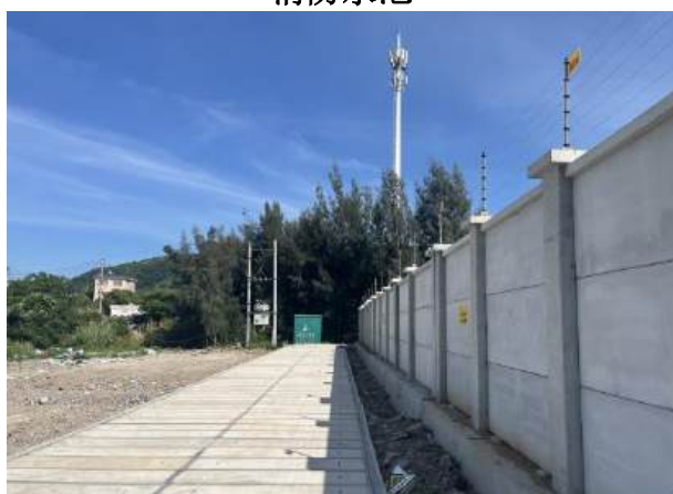
变电站东北侧
