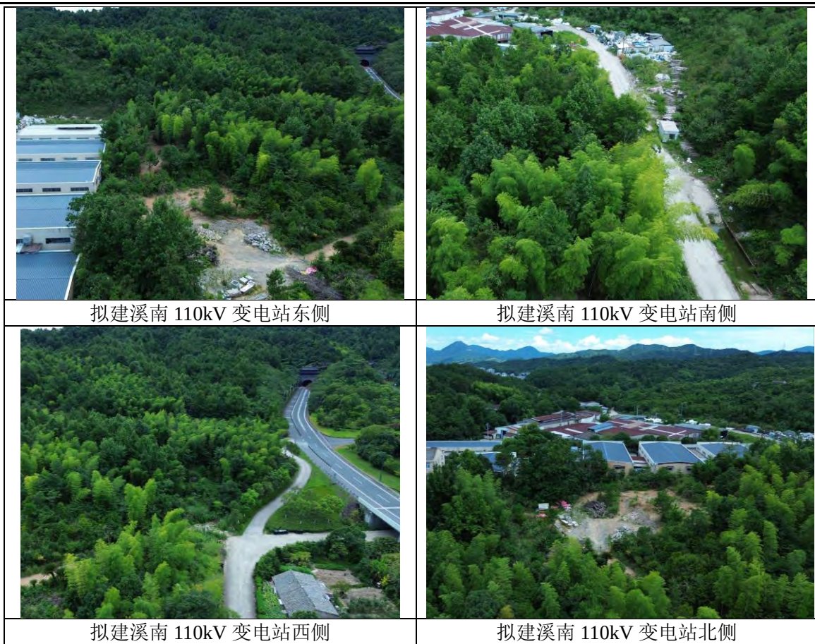
图 2-1 本工程环境现状
