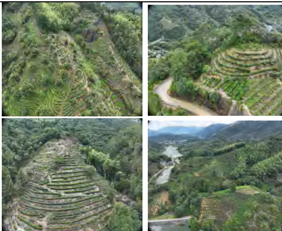
图 3-1 项目拟建区域现状情况航拍图
