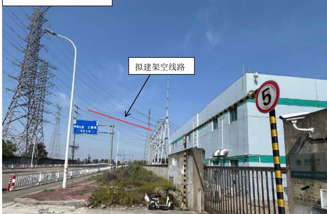
拟建架空线路周边现状
