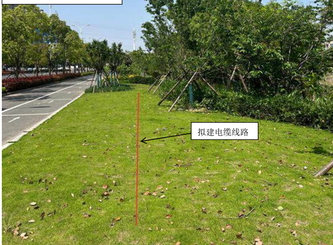
拟建电缆线路周边现状
