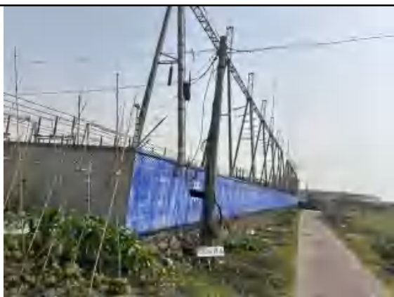
下变电站西北侧
