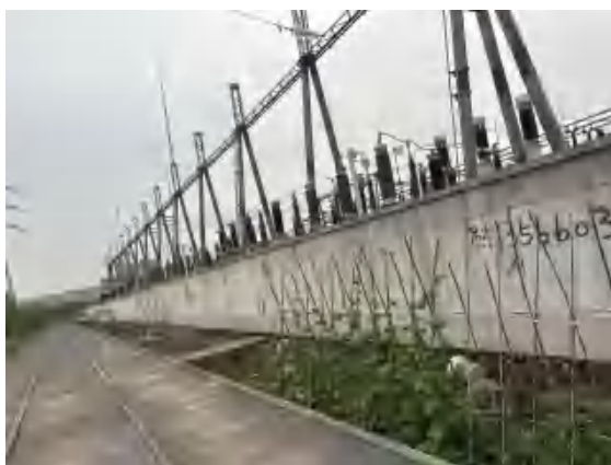
下应变电站东南侧
