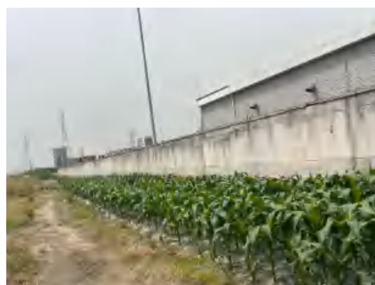
下应变电站西南侧
