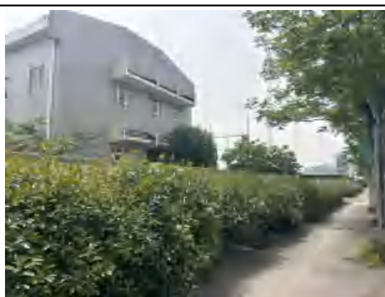
下变电站东北侧
