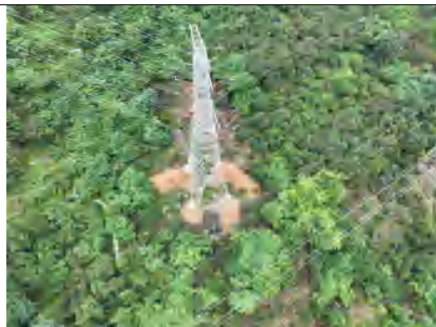
塔基迹地清理
