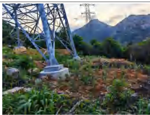
GK3 塔基植被恢复
