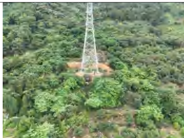
塔基迹地清理
