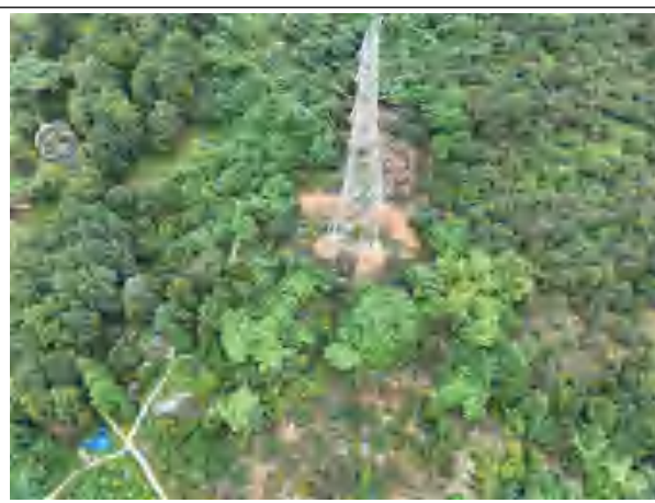
塔基迹地清理
