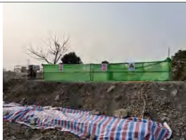
施工期堆土覆盖
