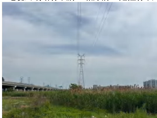
110kV 启营 1777 线/110kV 启金 1774 线双回架空线路沿线现状 2
