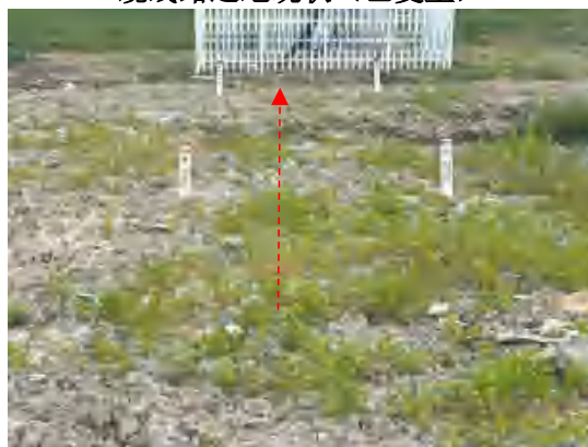
110kV 启海 1775 线单回电缆线路迹地现状（已 复垦）
