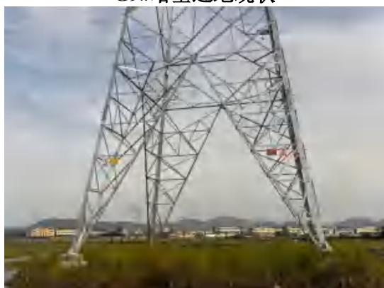
G24#塔基迹地现状
