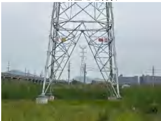
G2#塔基迹地现状
