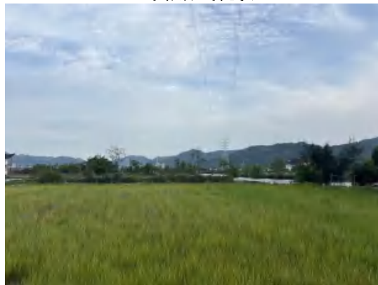
110kV 启营 1777 线/110kV 启金 1774 线双回架 空线路沿线现状 6
