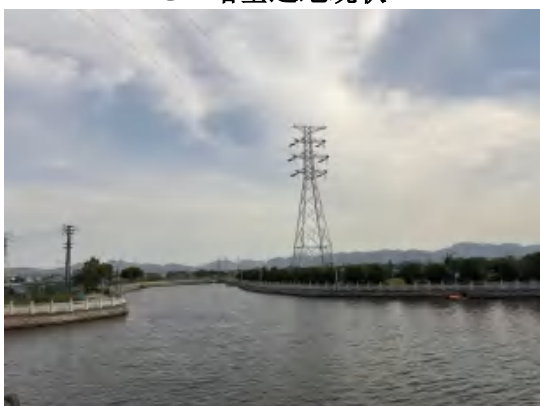
110kV 启营 1777 线/110kV 启金 1774 线双回架
