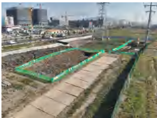
施工期环保措施照片（设置施工临时围挡）
