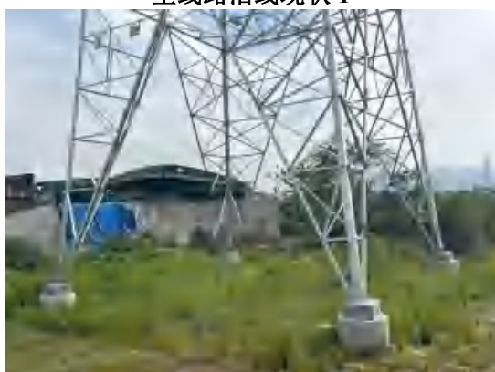
G9#塔基迹地现状
