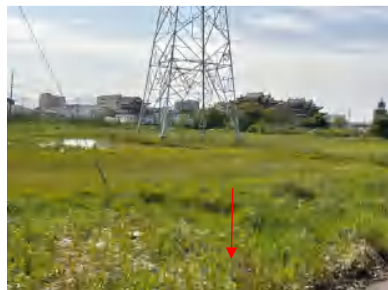
牵张场迹地现状 1（已复垦）
