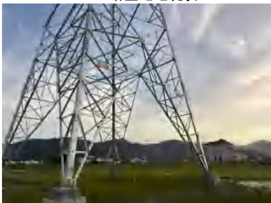
G37#塔基迹地现状
