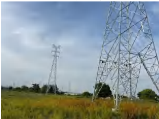
110kV 启营 1777 线/110kV 启金 1774 线双回架 空线路沿线现状 5
