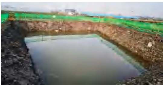
施工期环保措施照片（临时沉淀池）
