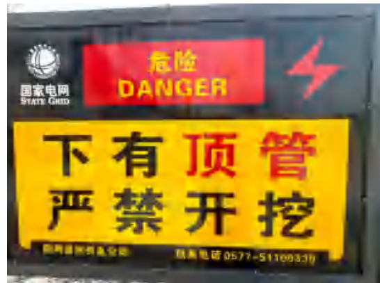
电缆高压危险标识
