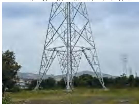
G18#塔基迹地现状
