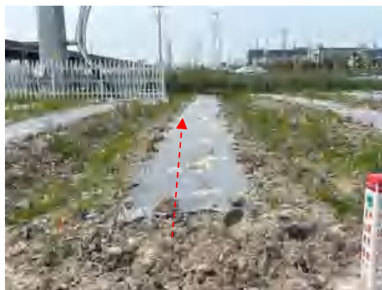
110kV 启松 1779 线单回电缆线路迹地现状（已 复垦）
