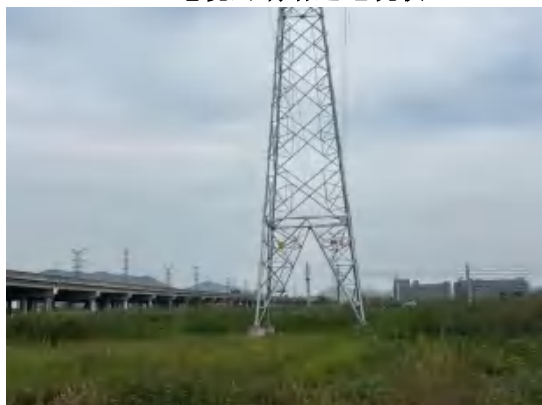
110kV 启营 1777 线/110kV 启金 1774 线双回架空线路沿线现状 1
