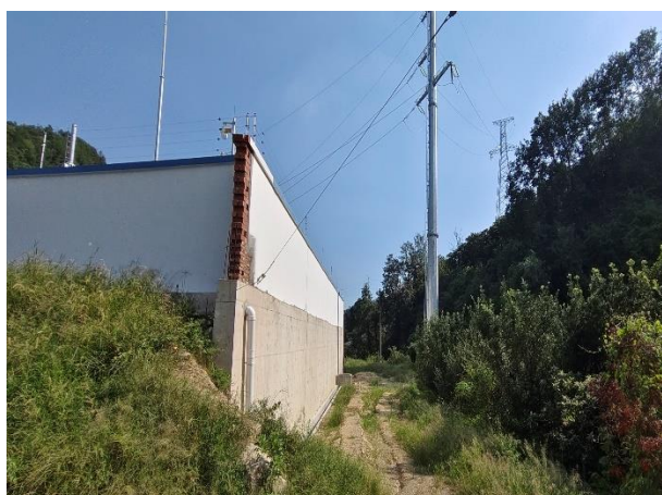
27#塔基及牵张场绿化
