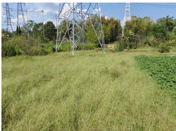
0#塔基及牵张场绿化
