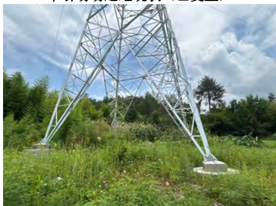
新电 1#塔基迹地现状（已覆绿）
