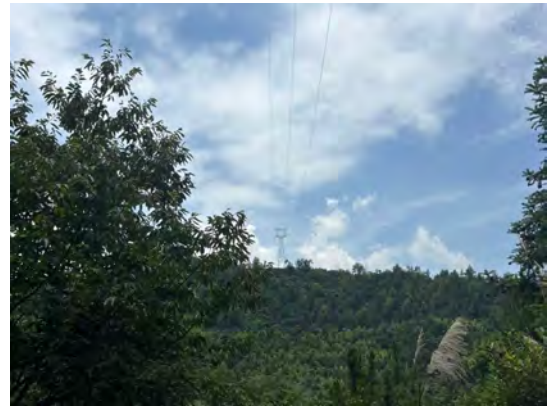
220kV 仙洲 2Q46 线沿林地走线现状 2
