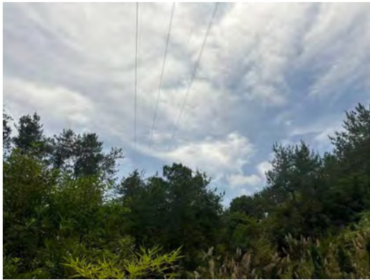
220kV 仙洲 2Q46 线沿林地走线现状 1
