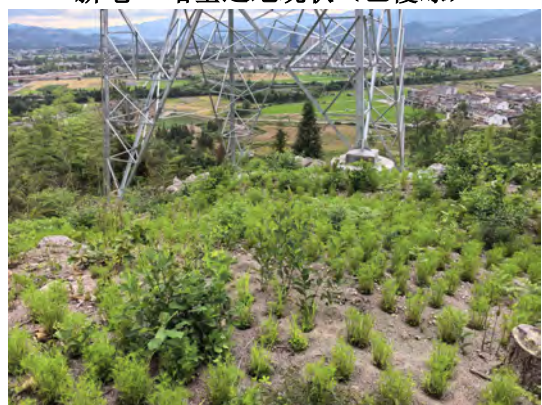
新电 4#塔基迹地现状（已覆绿）
