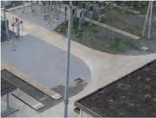
站内道路硬化及碎石敷设
