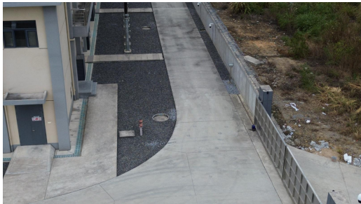
站内道路硬化
