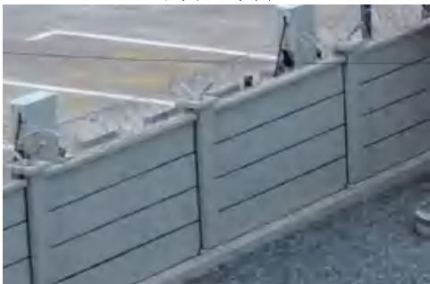
变电站警示装置
