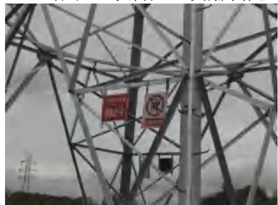
110kV 台岭 002 号/潭台 035 号塔警示标志
