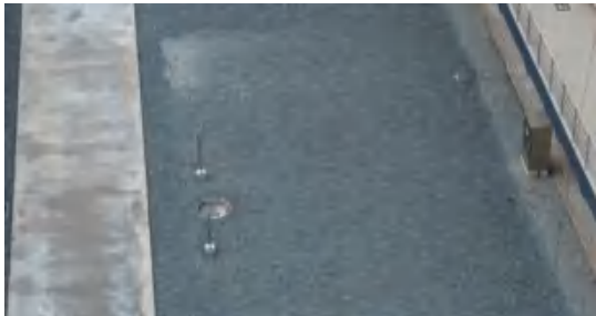
站内碎石敷设
