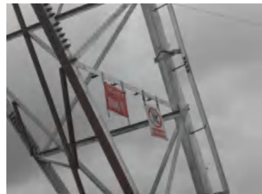
110kV 台岭 006 号/潭台 031 号塔警示标志
