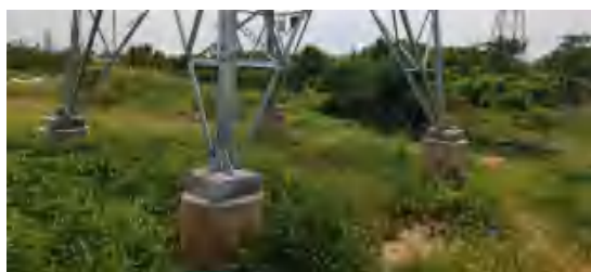
110kV 台岭 002 号/潭台 035 号塔基生态恢复
