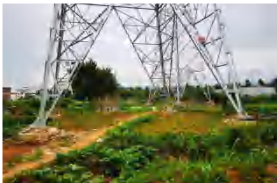
110kV 台岭 006 号/潭台 031 号塔基生态恢复
