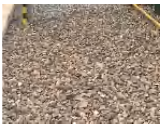
站内碎石硬化
