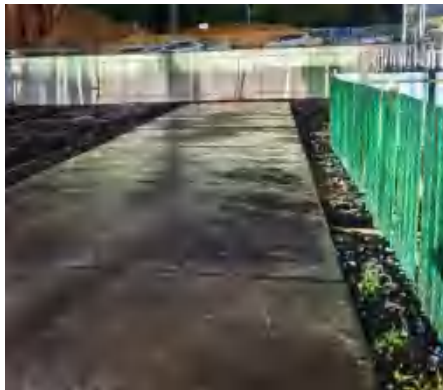
施工期环保措施（施工围挡）
