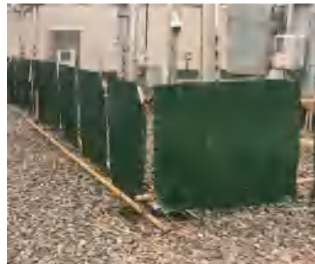
施工期环保措施（施工围挡）
