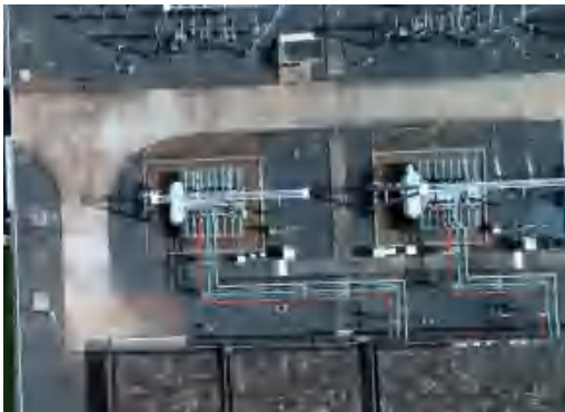
站内道路硬化
