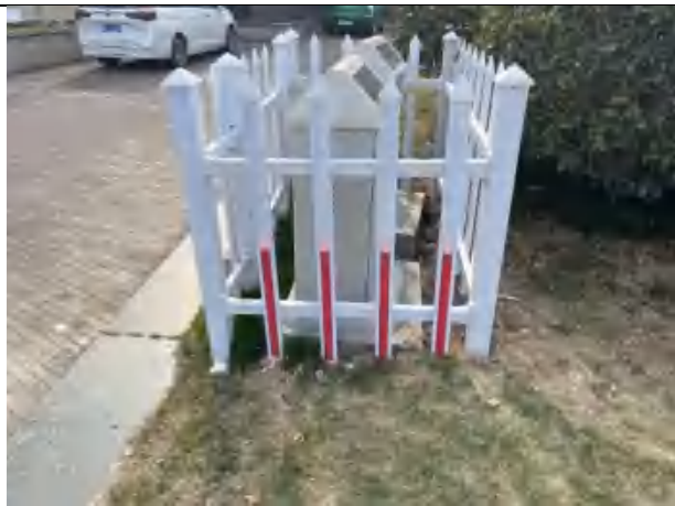
电缆线路保护接地箱 1
