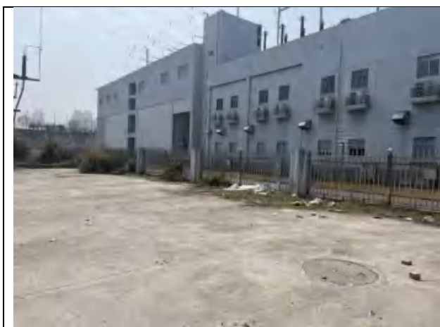
商务 220kV 变电站间隔扩建侧厂界
