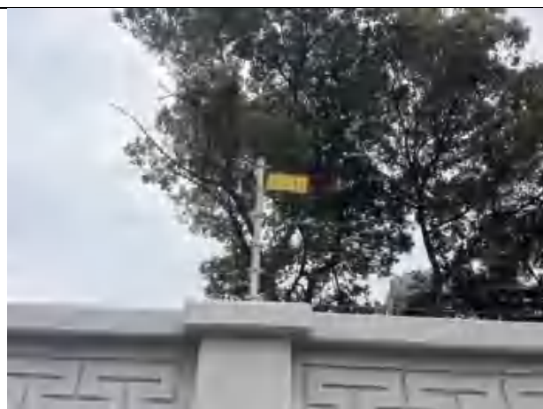
变电站警告标识牌 1
