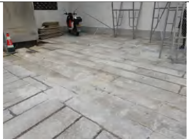
拆除塔基 2 土地已平整
