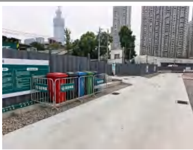
施工现场垃圾桶设置
