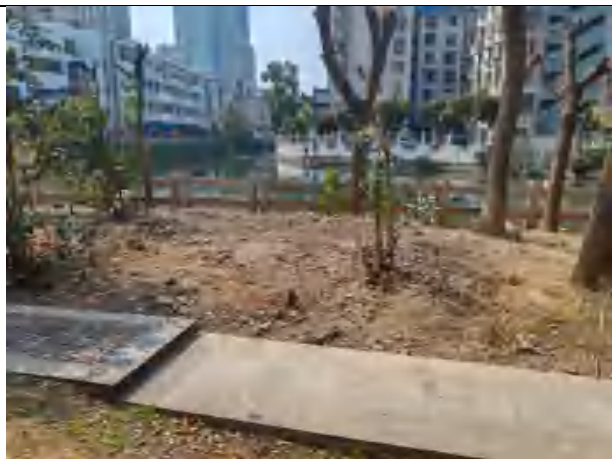
拆除塔基 1 植被恢复中
