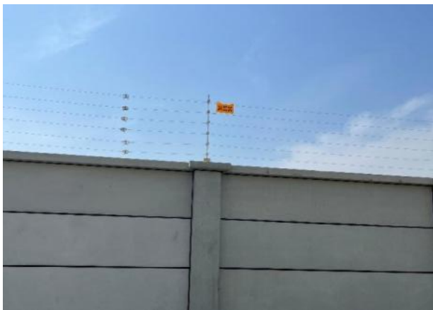
变电站警告标识
