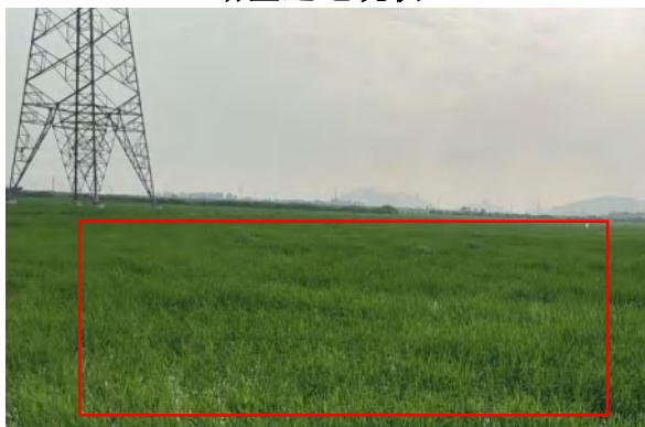
牵张场迹地现状
