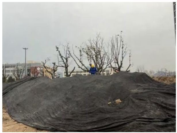
覆土防扬尘措施
