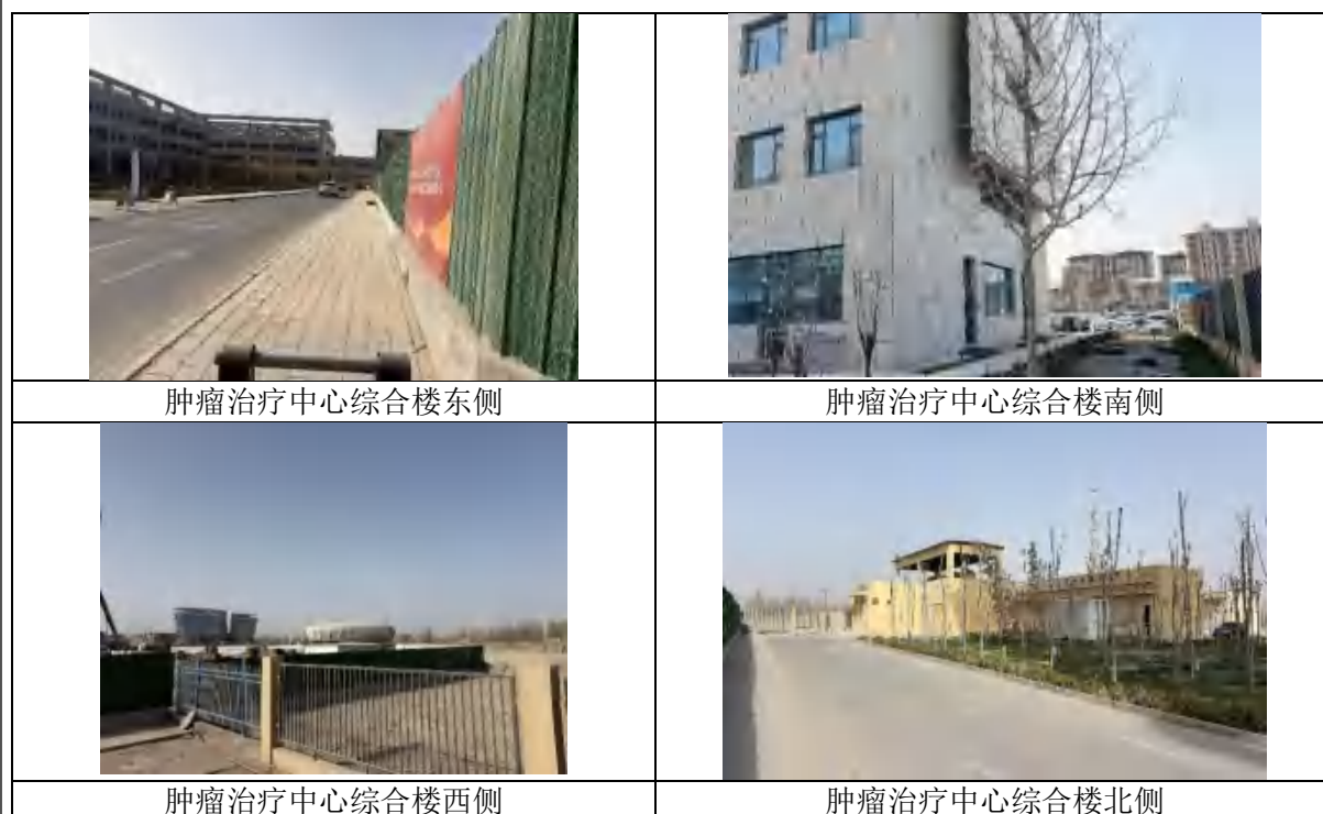
图 8.1-1 项目场址现状图
