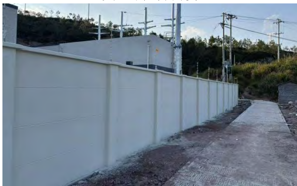
变电站厂界北侧
