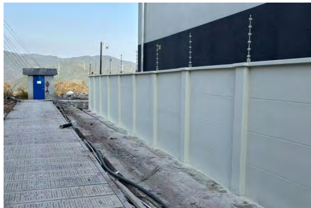
变电站厂界西侧
