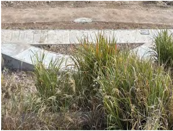
电缆沟迹地现状
