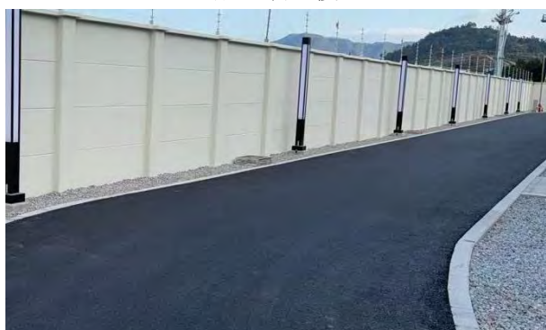
站内道路硬化
