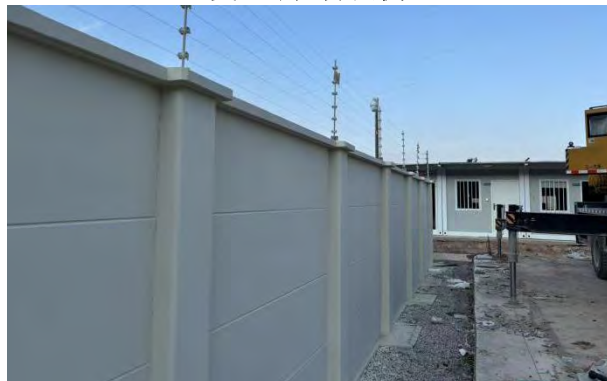
变电站厂界东侧
