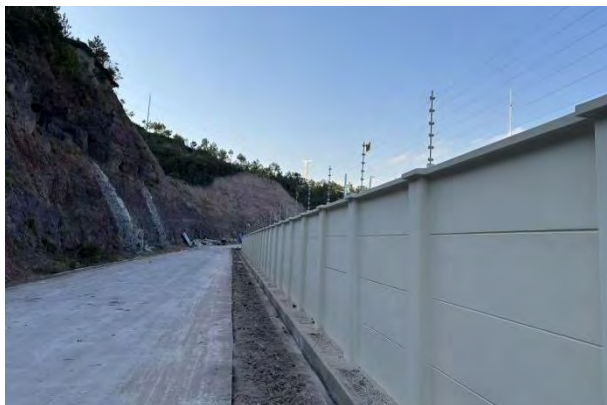
变电站厂界南侧
