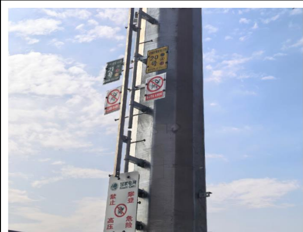
塔基危险标识 3
