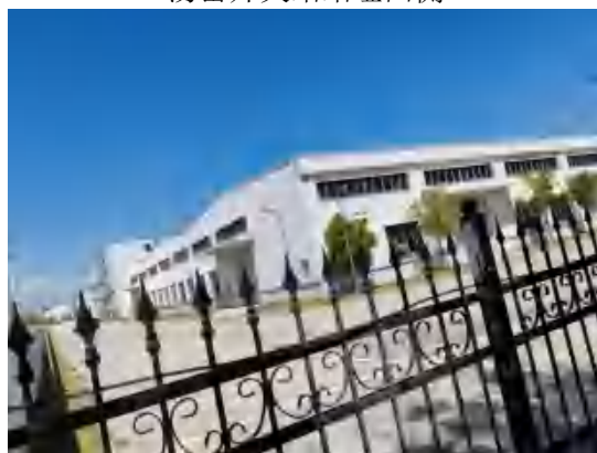
汤岙开关站站址东侧
