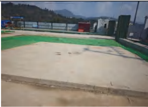
施工作业时密目网遮盖
