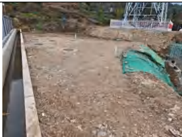
电缆用地恢复与平整
