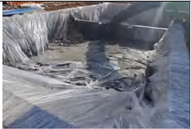
施工设置临时沉淀池
