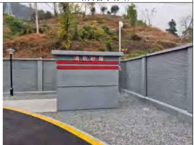
站内消防砂箱
