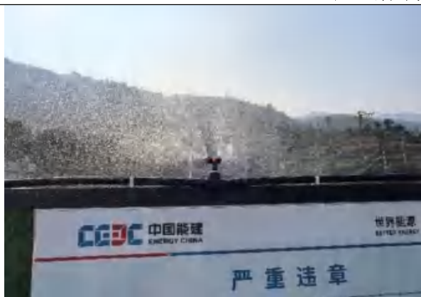
施工喷水降尘
