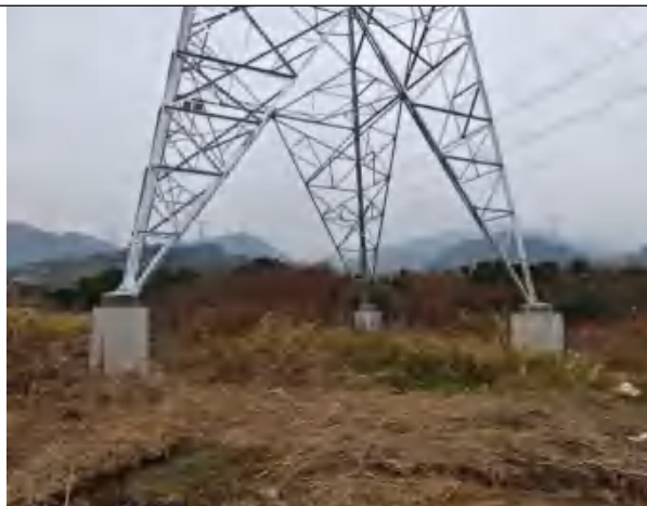
L2#塔基现状
