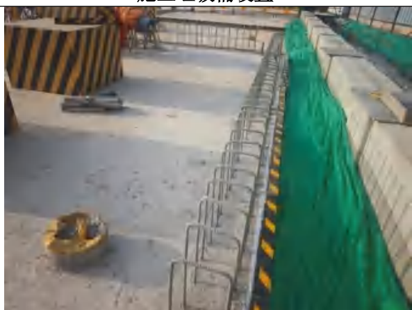
施工集水沟密目网遮盖
