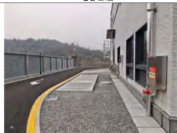
站内道路硬化与碎石铺盖
