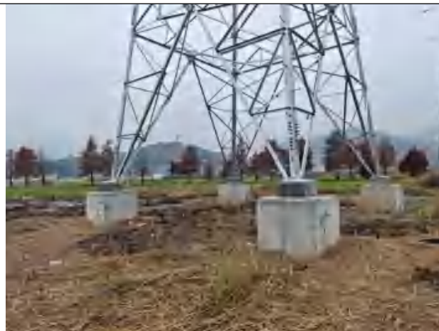
G1#塔基现状
