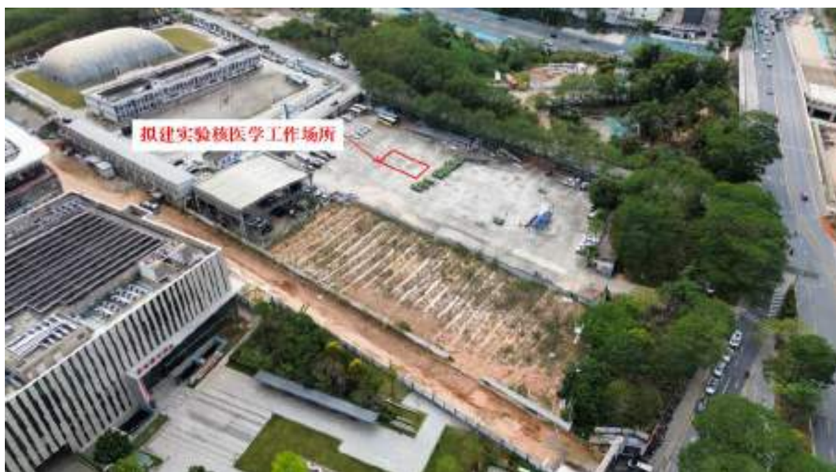
图 8-1 项目现状照片
