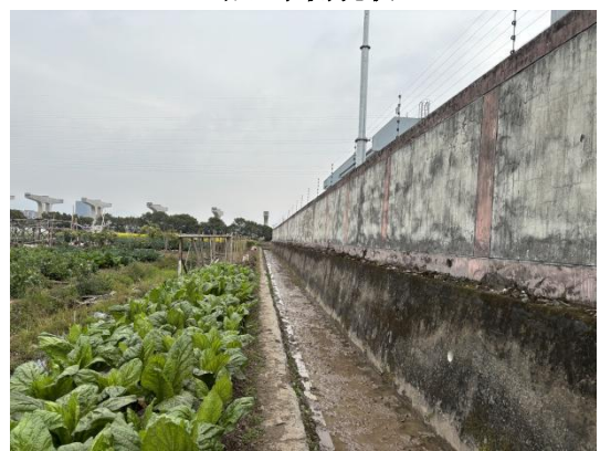
站址西侧现状
