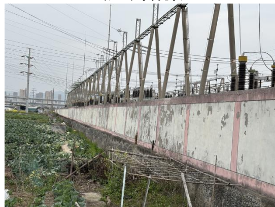
站址南侧现状
