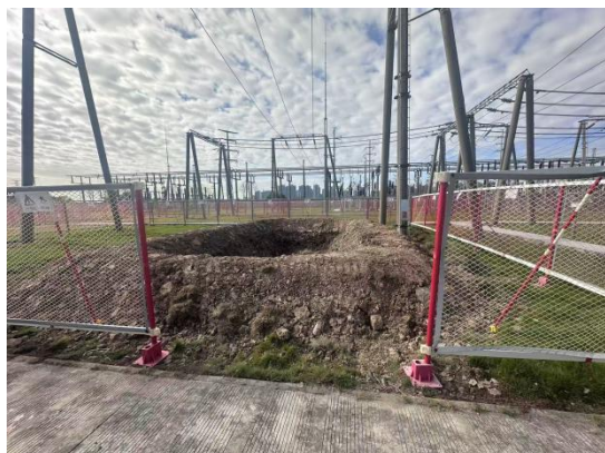
施工期基坑开挖及安全隔离防护
