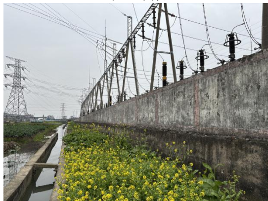
站址北侧现状
