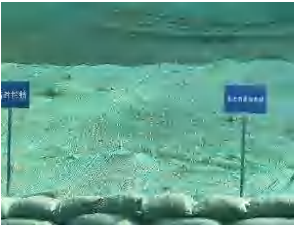
施工期环保措施照片(堆土苫盖)
