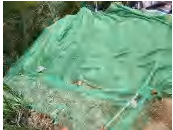
施工期环保措施照片(堆土苫盖)
