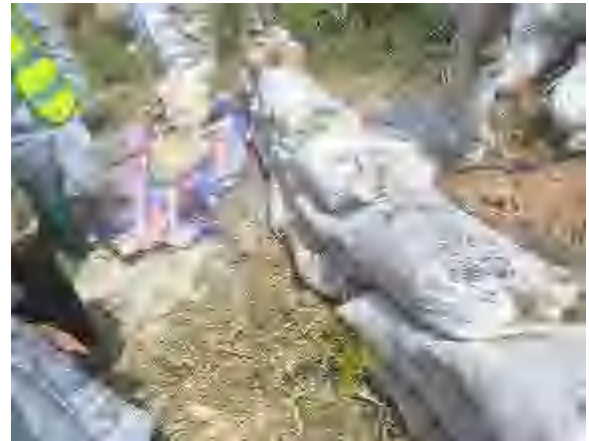
施工期环保措施照片（表土剥离后编织袋堆放）
