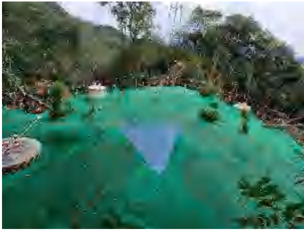
施工期环保措施照片(堆土苫盖)
